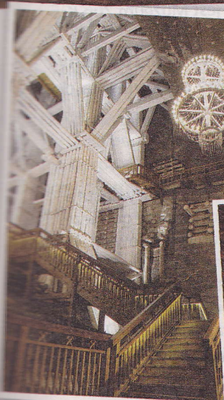
Imponujące konstrukcje ciesielskie podtrzymują stropy i tworzą wygodne przejścia
